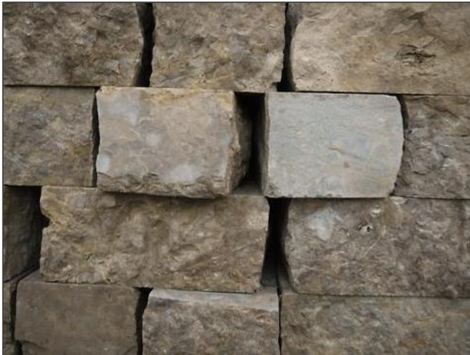
Schichtmauerwerk Dolomit wilder Verband
