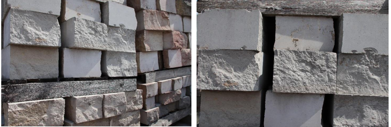
Schichtmauerwerk Jura Kalkstein wilder Verband
