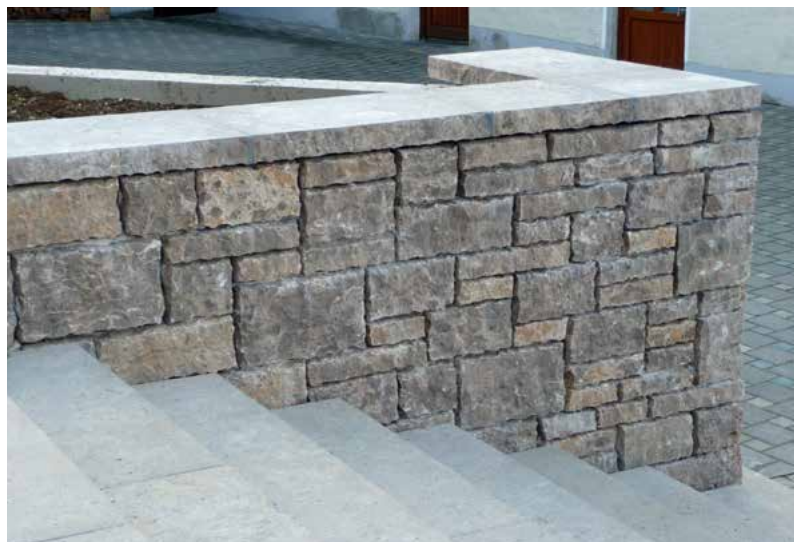
Pfraundorfer Dolomit, Systemmauerwerk
