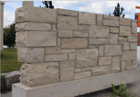
Schichtmauerwerk Jura Kalkstein wilder Verband
